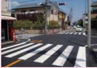
劣化していた道路の 舗装改修工事完了@前地地区
