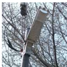
街路灯整備@どんぐり山公園 公園の防犯灯をLED化、新設し安全確保をはかる
