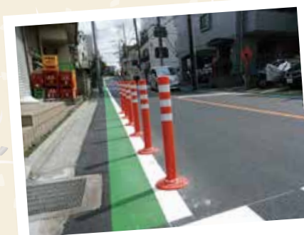
通学路の安全対策修繕
