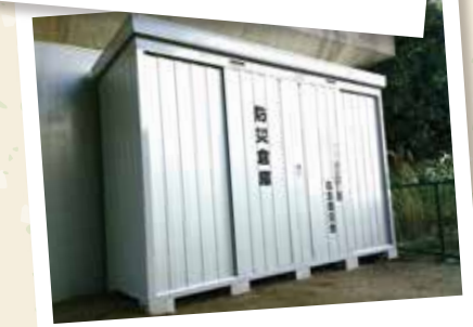
防災倉庫の設置
