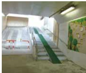
本太地下道の整備
